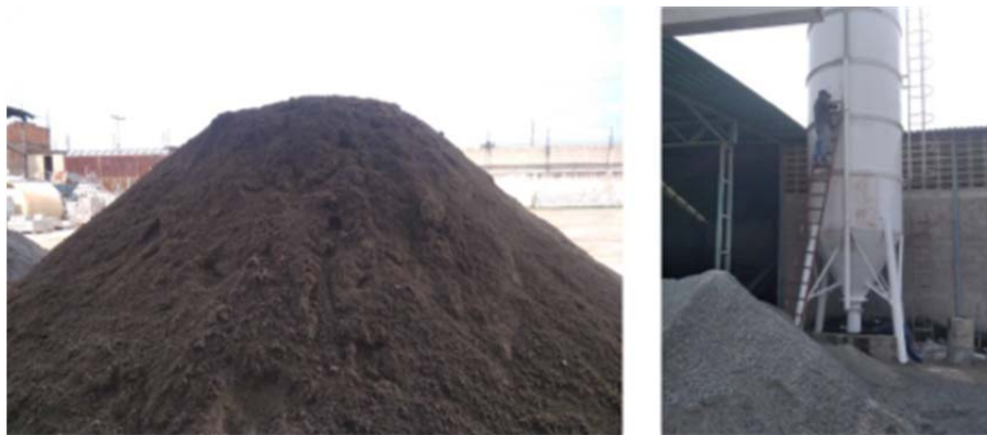
Figura 14. Arena a granel y silo de cemento.
