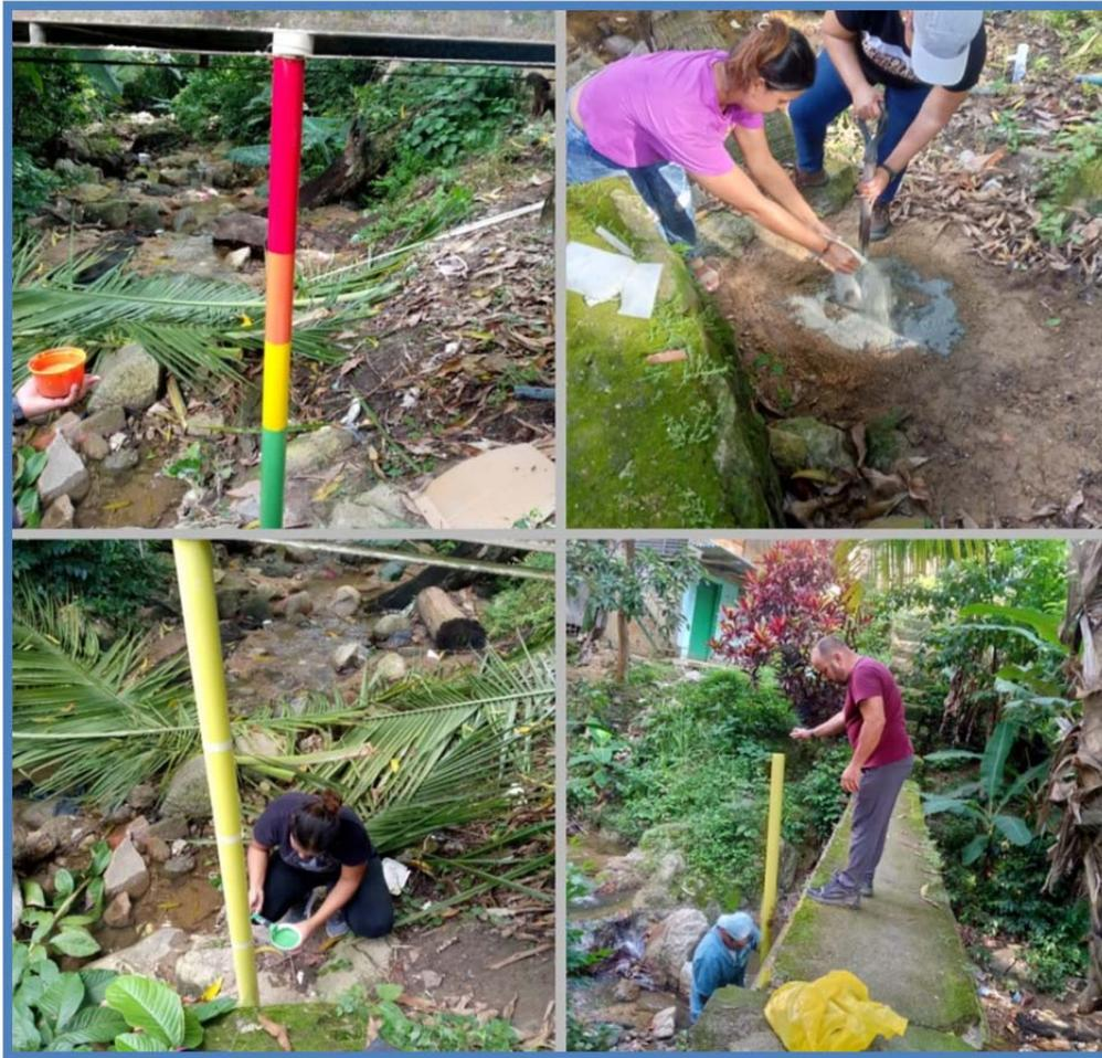
Figura 43. Instalación de la regla limnimétrica.
